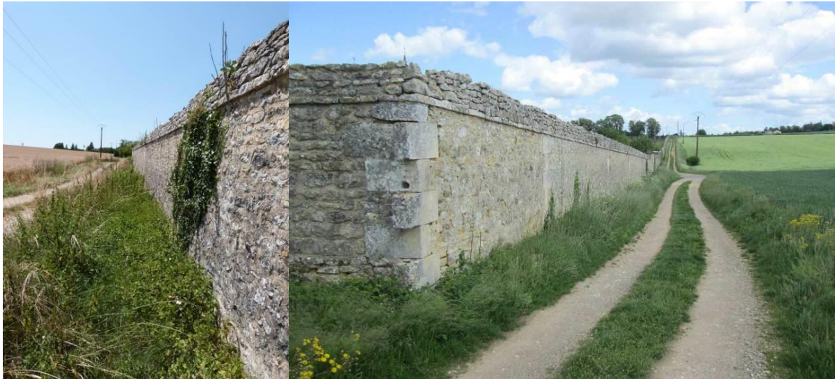
Figure 31 : Bande enherbée et mur d'enceinte
