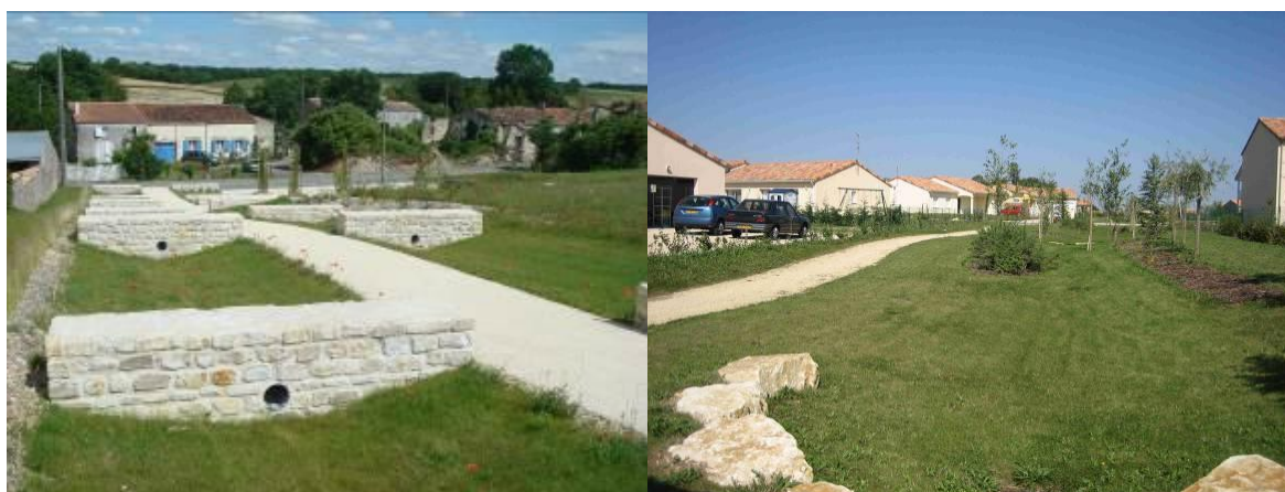
Figure 83 : Photographies de principes des redans des ouvrages de collecte des eaux pluviales le long du chemin du Potet
